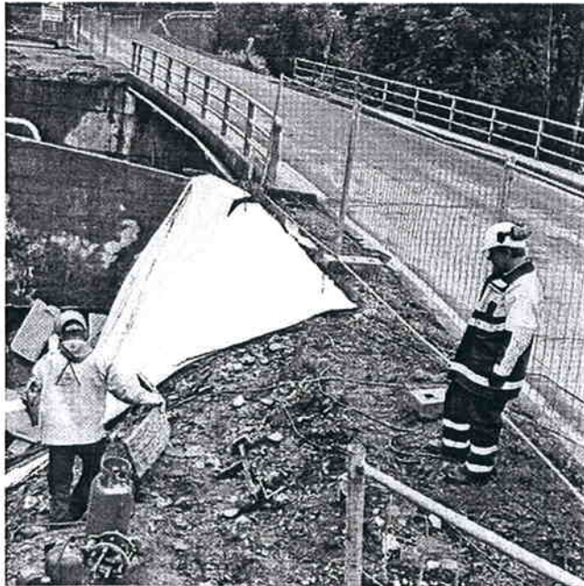
Erdgas-Leitung wurde beim Geschriet-Bach in Döbriach hergestellt STÖL LIN (3)
