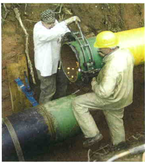
Was nicht passt, wird passend gemacht ...? Nein, nicht ganz so einfach ist es, wenn die Rohrnetz-Fachleute an Leitungen arbeiten. Hier wird das letzte, einige Zentimeter zu lange Teilstück an einem Ende gekürzt, anschließend wird es (großes Bild) an beiden Leitungsenden verschweißt.
