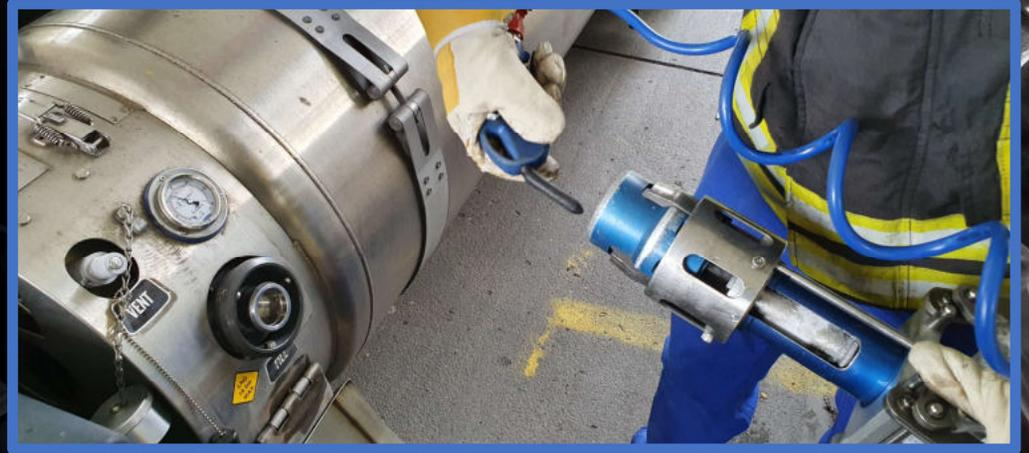
Setzen Sie dafür die Kupplung auf das Ventil und drücken die beiden Hebel nach vorne.
