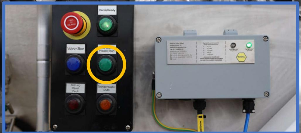
Nehmen Sie den Taster in der Nähe der Zapfpistole in die Hand und halten Sie den Taster bis zum Ende der Betankung gedrückt.
