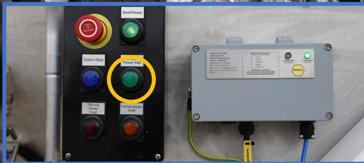
Halten Sie den Taster bis zum ende der Betankung gedrückt. Drücken Sie den Taster nicht erneut wenn die Anlage abschaltet (Überfüllungsgefahr).
